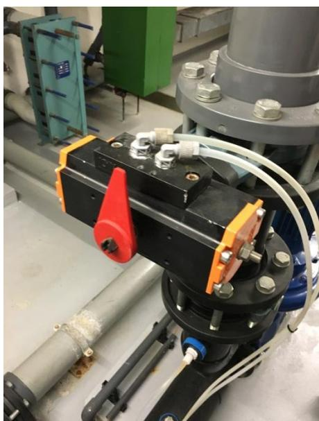
Abbildung 99: pneumatische Drosselklappe; PVC-Rohre
