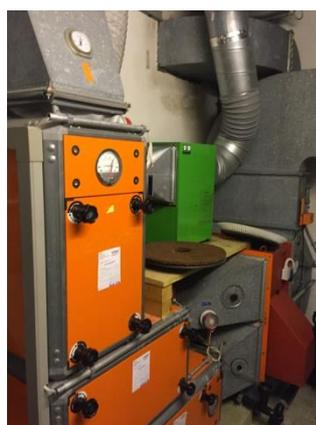
Abbildung 56: Technikraum mit Lüftungsmonoblock Garderoben
