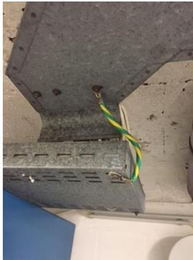
Abbildung 157: Potential Ausgleich einer Kabeltrasse
