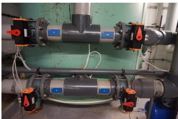
Abbildung 105: Filter, pneumatische Klappen, PVC-Rohre
