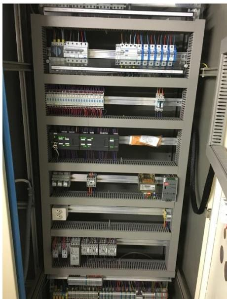
Abbildung 114: Schaltschrank von Siemens Typ S7-200
