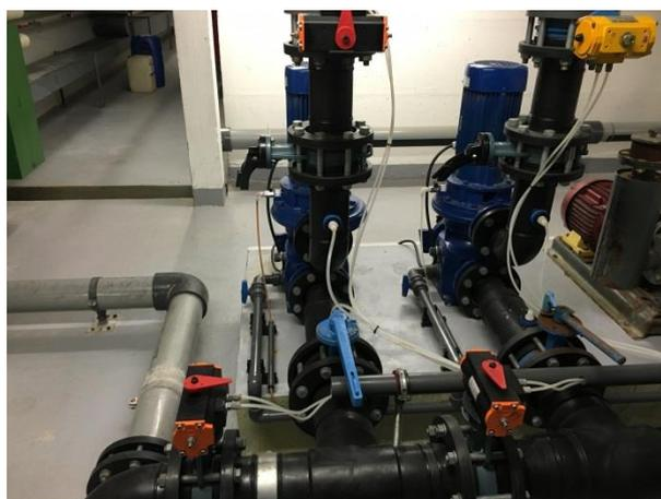
Abbildung 107: Filterpumpen UNIBAD; PE-Rohre
