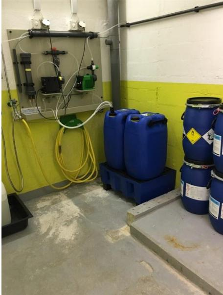
Abbildung 118: Neutralisierung mit Schwefelsäure
