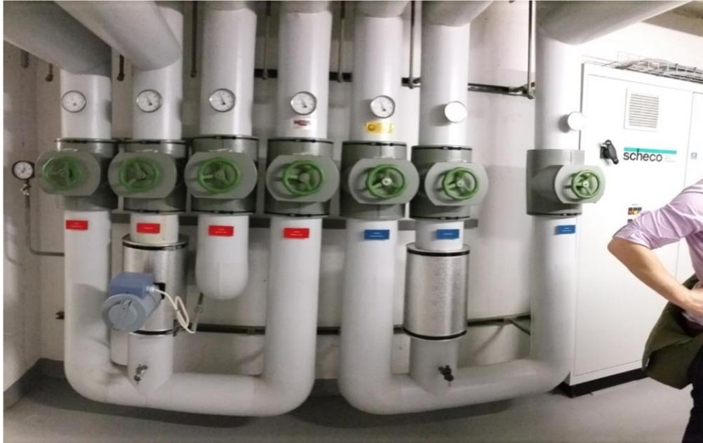
Abbildung 146: Frischwasserverteilung vorbildlich in Schuss und gedämmt
