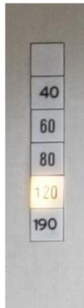
Abbildung 128: selbstleuchtende Wassertiefen-Anzeige in der Schwimmhalle
