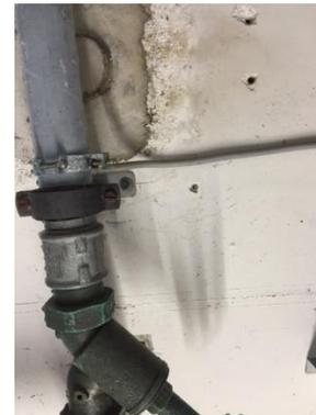
Abbildung 158: Haupterdungsanschluss
