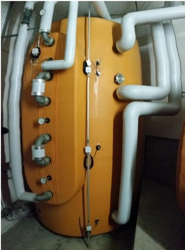
Abbildung 133: Solar-Pufferspeicher
