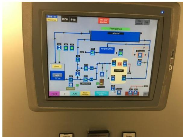
Abbildung 115: Touchpanel des Badewasser-Schaltschranks
