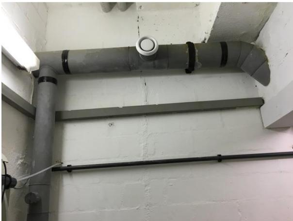
Abbildung 119: Lüftungsstutzen im Chemieraum
