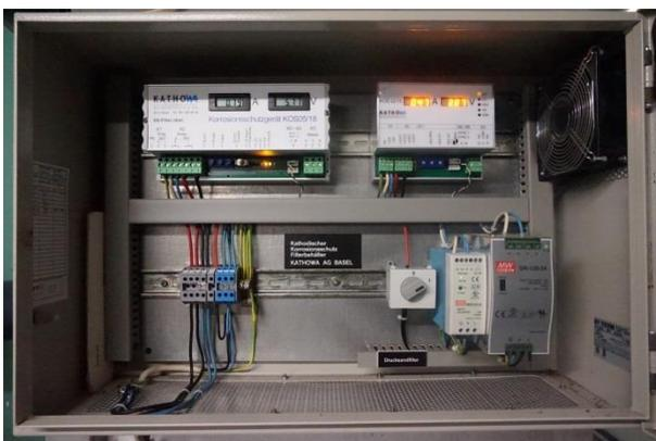
Abbildung 102: Neuwertige Kathodenschutzanlage der Marke KATHOWA
