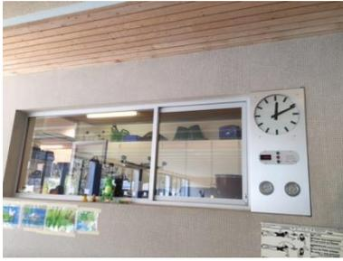
Abbildung 174: Uhr, Hubbodenanzeige, Temp. Anzeige im LSB
