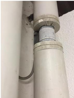
Abbildung 156: Erdungsanschluss
