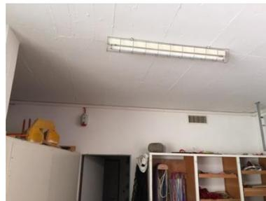
Abbildung 166: Leuchten mit Schutzgitter in Geräteraum
