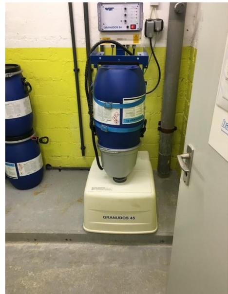
Abbildung 121: Die Desinfektion erfolgt mit Calciumhypochlorit (Granudos 45)
