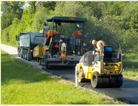
Sanierung Freechtstrasse (Belagseinbau)
