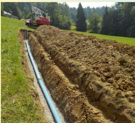
Leitungsbau Ausbau Zone Chellerloch
