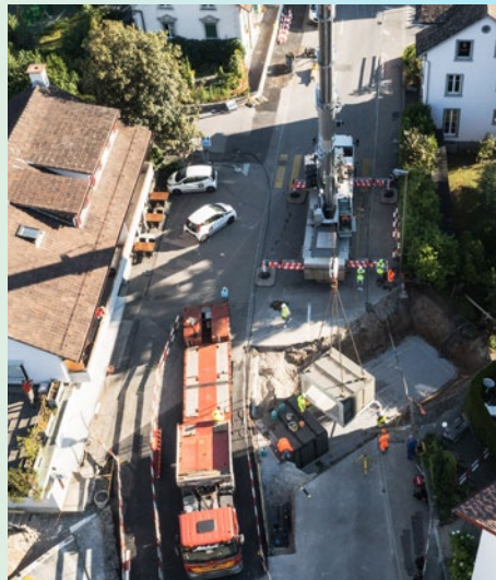
Bachdurchlass Rütibach, Versetzen der Betonelemente mit Pneu Kran
