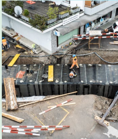
Ersatz-Durchlass Rütibach Dürntnerstrasse
