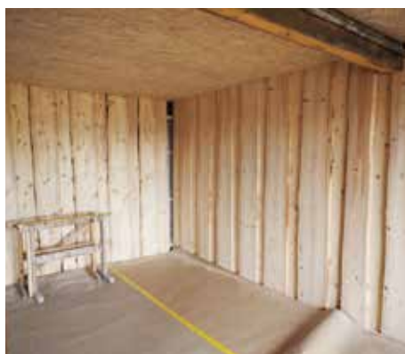
Ein Blick in den umgebauten Stall
