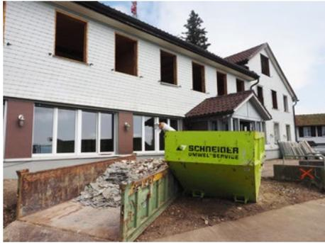
Im Berggasthaus auf dem Bachtel sind die Fenster entfernt und Handwerker sind daran, die Asbestrückstände fachgerecht zu entsorgen. Für die gröbere Arbeit steht bereits ein Bagger bereit und der Parkplatz auf Bachtel-Kulm ist ein Baustellen-Installationsplatz geworden.
