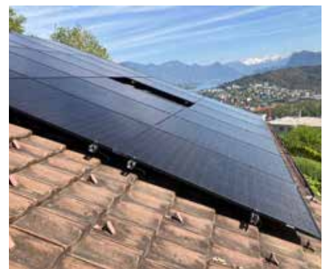
Montage der Solarpanels auf einem Ziegeldach
