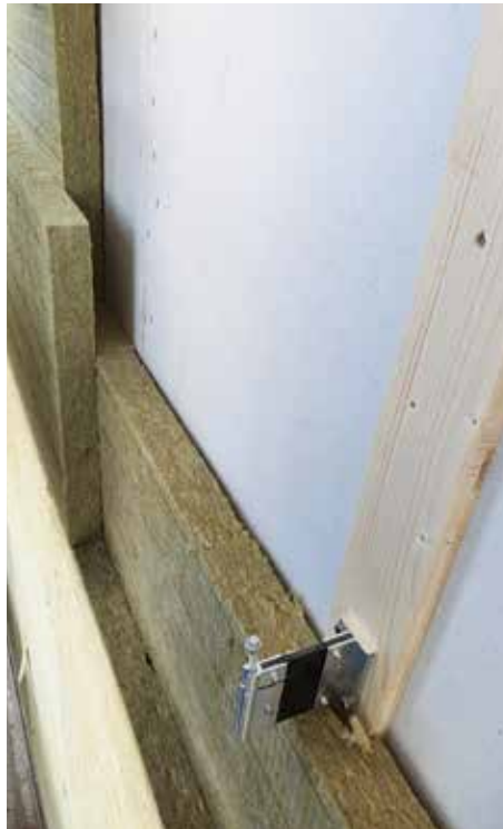
Zweischichtige Dämmung an einem Gebäude in der Steigbreite.
