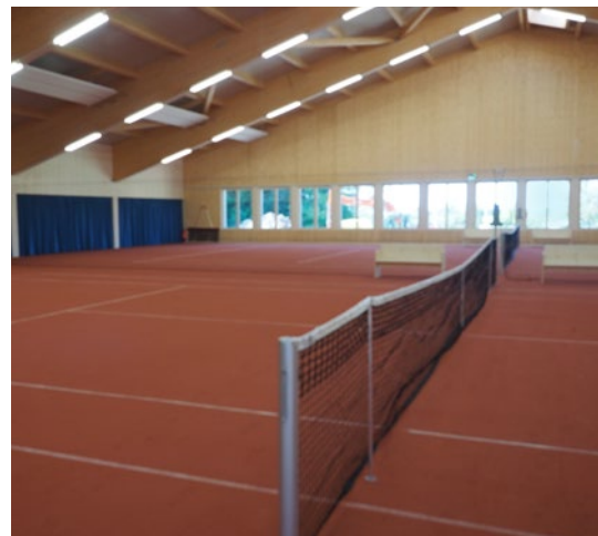
Rund 215 m 3 unbehandeltes Schweizer Holz bilden die Konstruktion der Halle. Grosse Fenster sowie Lehmsteine führen zu einem angenehmen Klima und einer guten Luftqualität.
