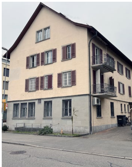
Das ehemalige Bankgebäude am Bahnhof
