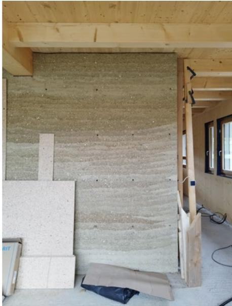
Projekt «Earth Batteries»: Stampflehm als thermischer Massespeicher in einem Vollholzhhaus, ausgeführt durch Kollektiv Erdikal.
